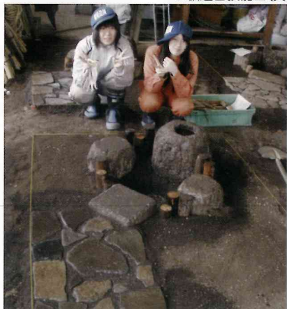
▲蹲踞、延べ段施工実習
