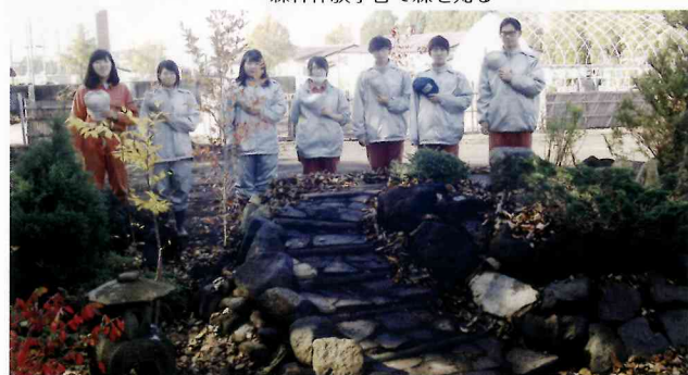
▲3年次に図面の庭を施工し、形に現す
